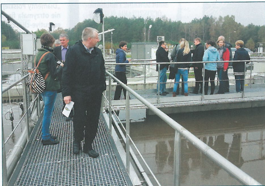
Oczyszczalnia Ścieków KRYM w Radzyminie
