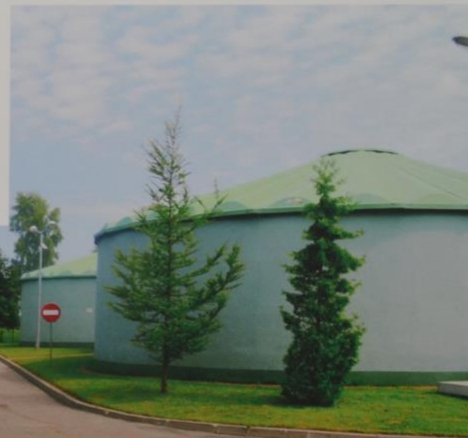
Oczyszczalnia Ścieków w Długiej Kościelnej po modernizacji
