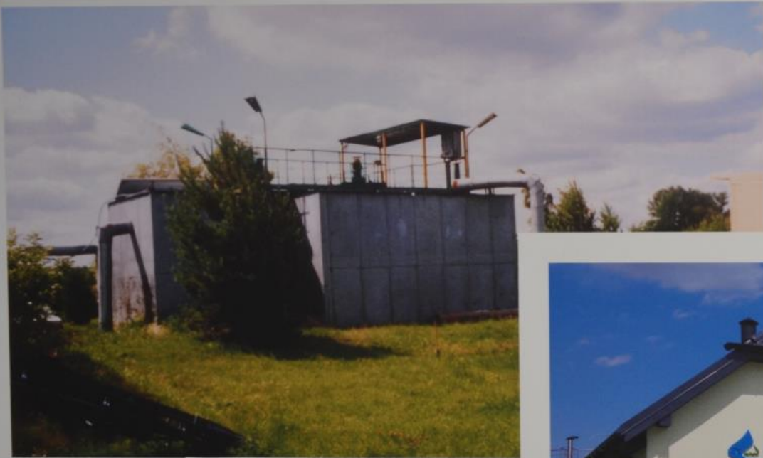
Oczyszczalnia Ścieków w Długiej Kościelnej przed modernizacją
