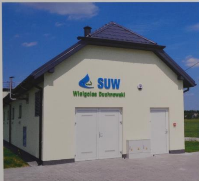
SUW Wielgolesie Duchnowski po modernizacji
