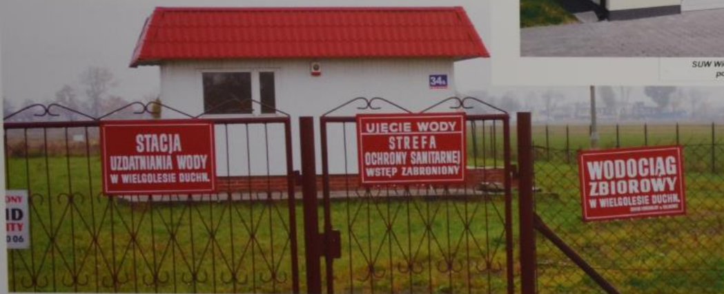
SUW Wielgolesie Duchnowski przed modernizacją
