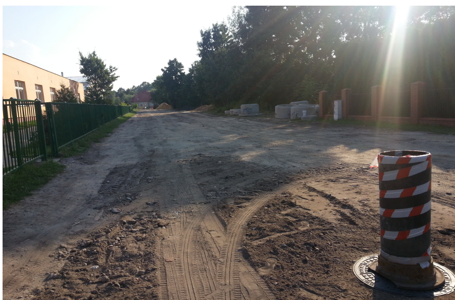
Naprawa studzienki kanalizacyjnej i wymiana włazów w ul. Pułaskiego
