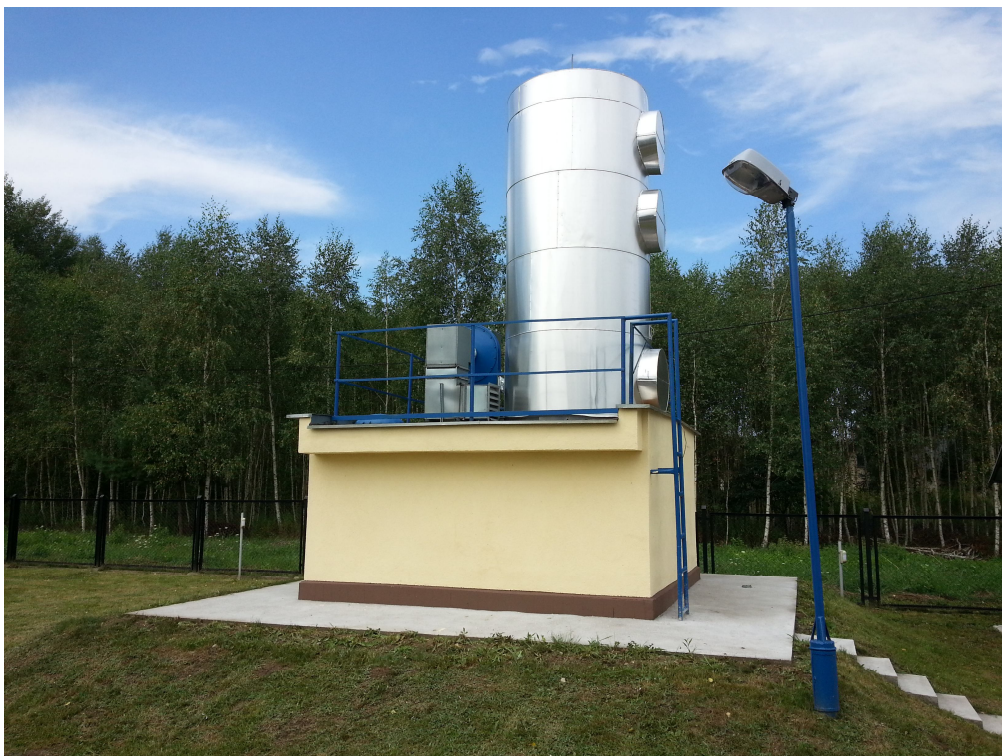
Zbiornik aeracyjny po modernizacji Stacja Uzdatniania Wody w Okuniewie
