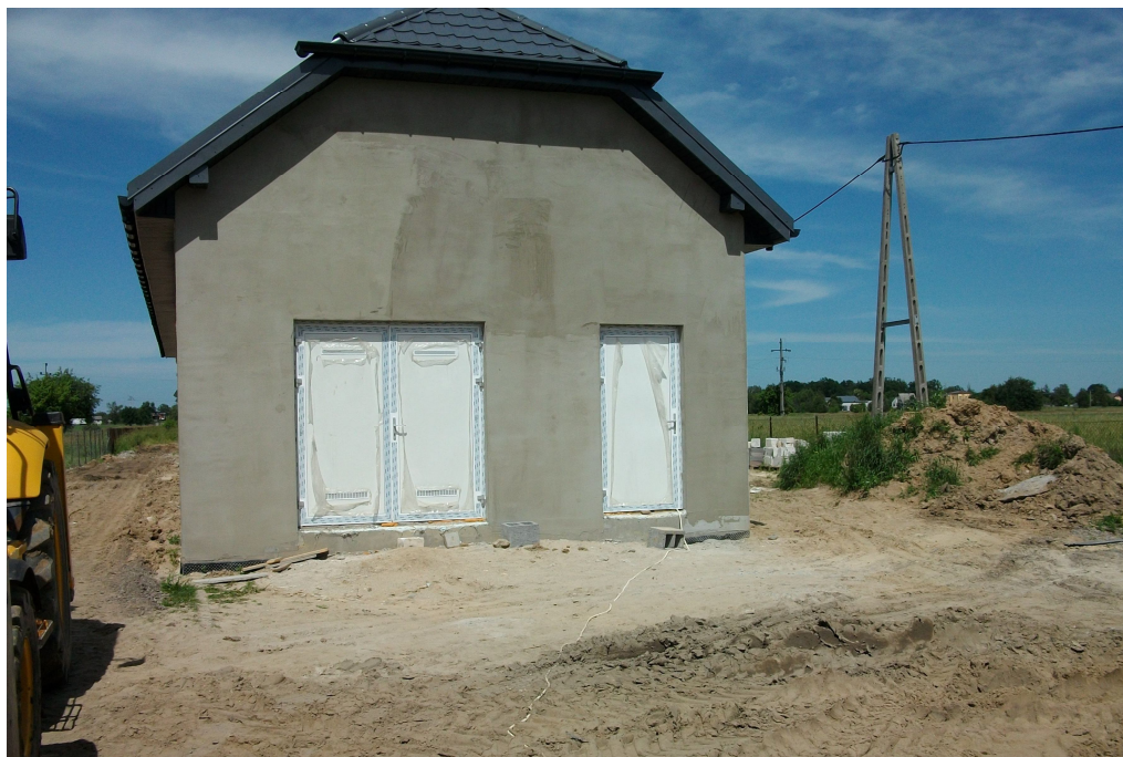
Budynek Technologiczny Stacji Uzdatniania Wody w Wielgolesie Duchnowskim widok od frontu.
