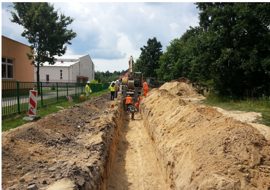
Budowa sieci kanalizacyjnej w ul. Pułaskiego
