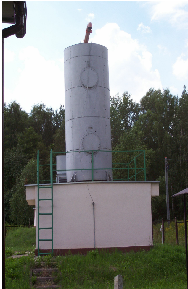
Zbiornik aeracyjny przed modernizacją Stacja Uzdatniania Wody w Okuniewie
