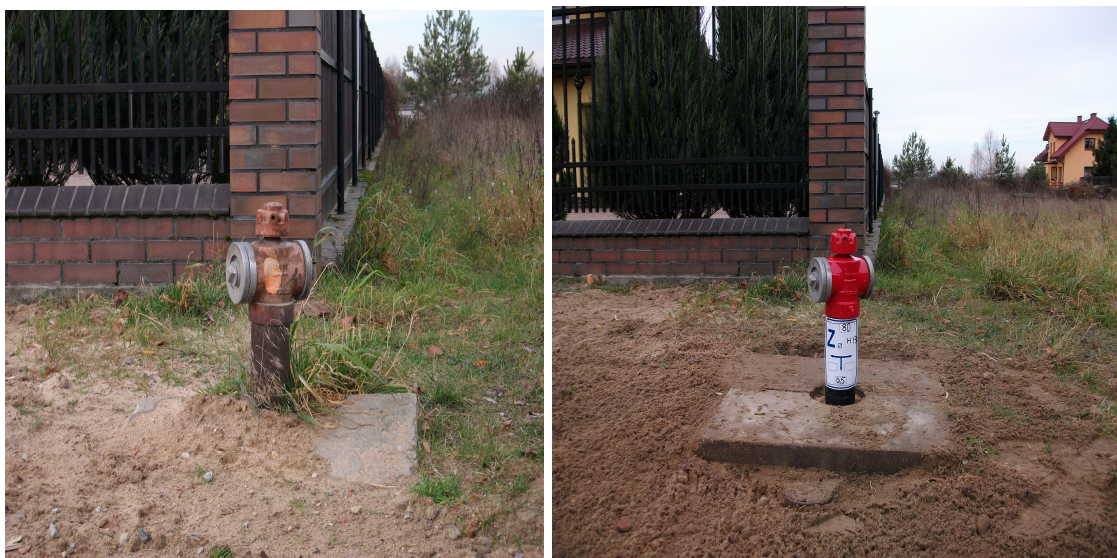
Hydrant przed pracami konserwacyjnymi Hydrant po pracach konserwacyjnych
